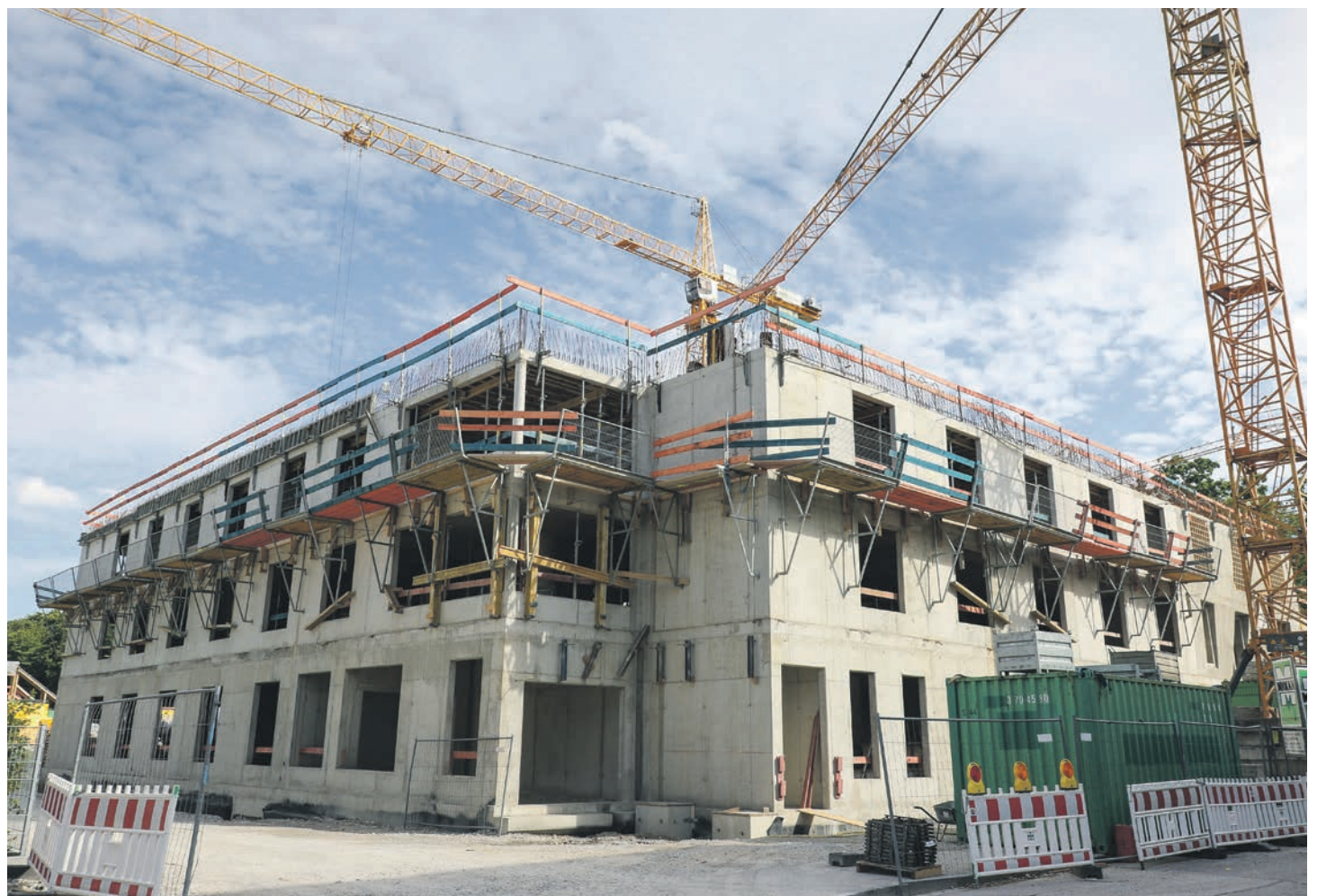
Der Bau wächst unaufhaltsam in die Höhe.
