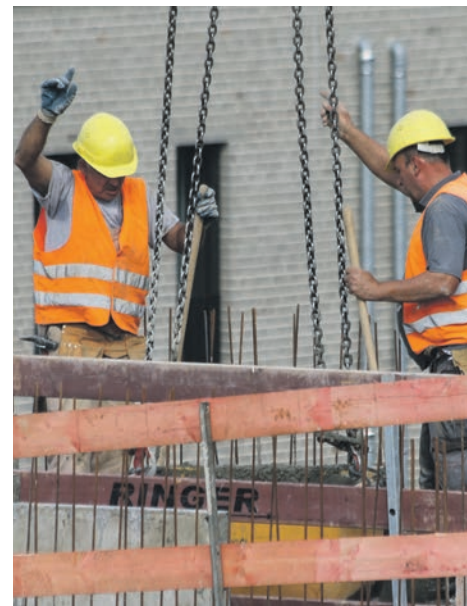
Start der Bauarbeiten war im Dezember.
